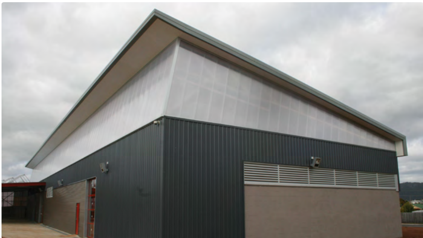
”George Town Trade Centre Tasmania”, אוסטרליה | אדריכל: Loop | יישום: קירוי צד | סוג סנפלי: לבן אייס 10 מ”מ
