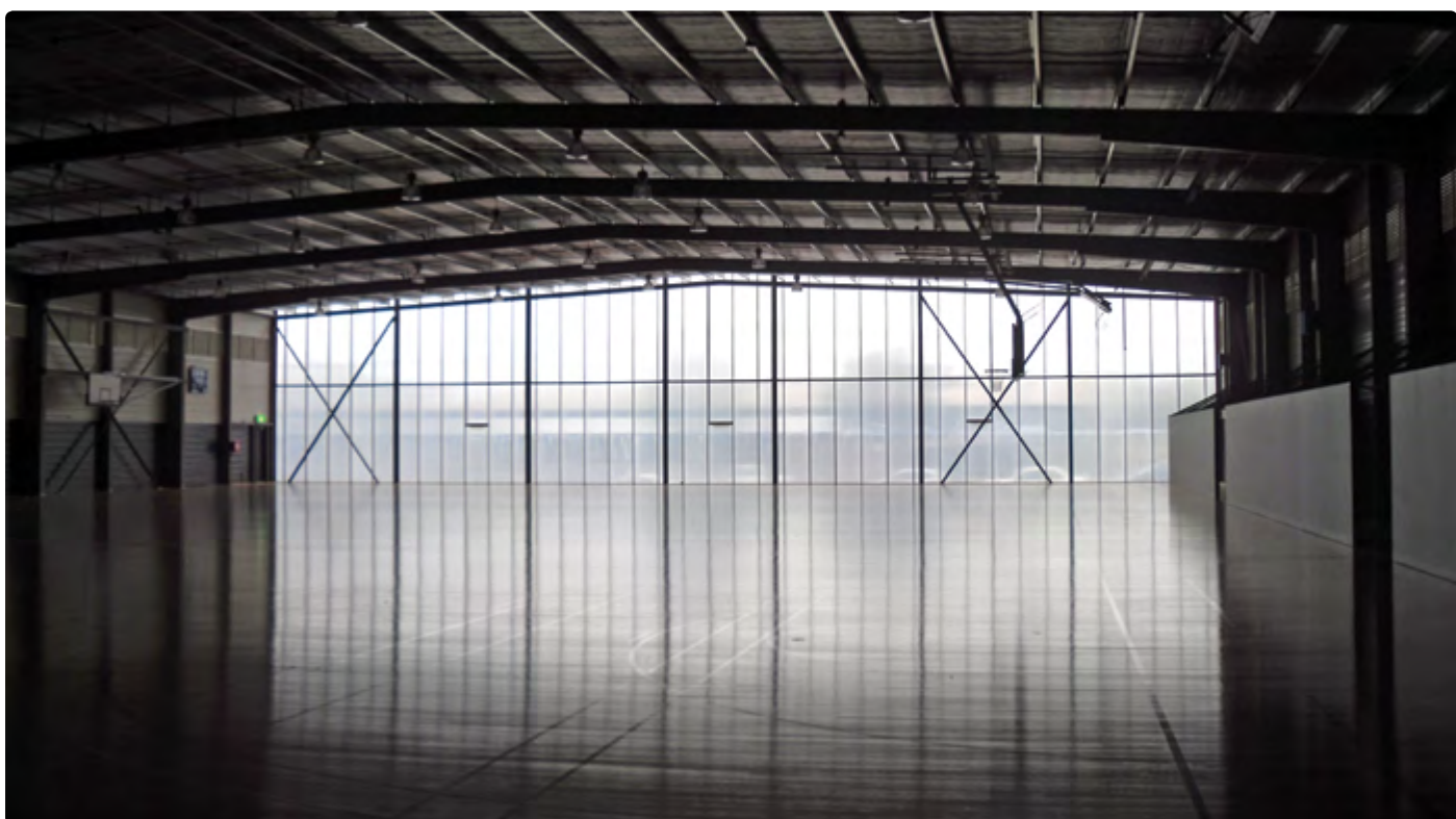
אולם ספורט קהילתי, אוסטרליה | אדריכל: Peddle Thorp | יישום: קיר-מסך, 370 מ"ר | סוג סנפלי: סולר אייס 18 מ"מ
