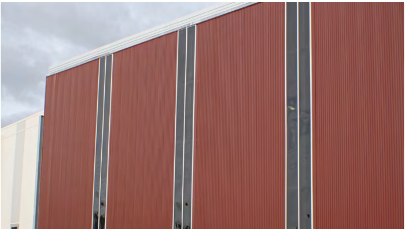
מפעל לגבינה - ברני, אוסטרליה | יישום: פתחי צד תעשייתיים - 70 מ"ר | סוג סנגלייזינג: שקוף 4/600
