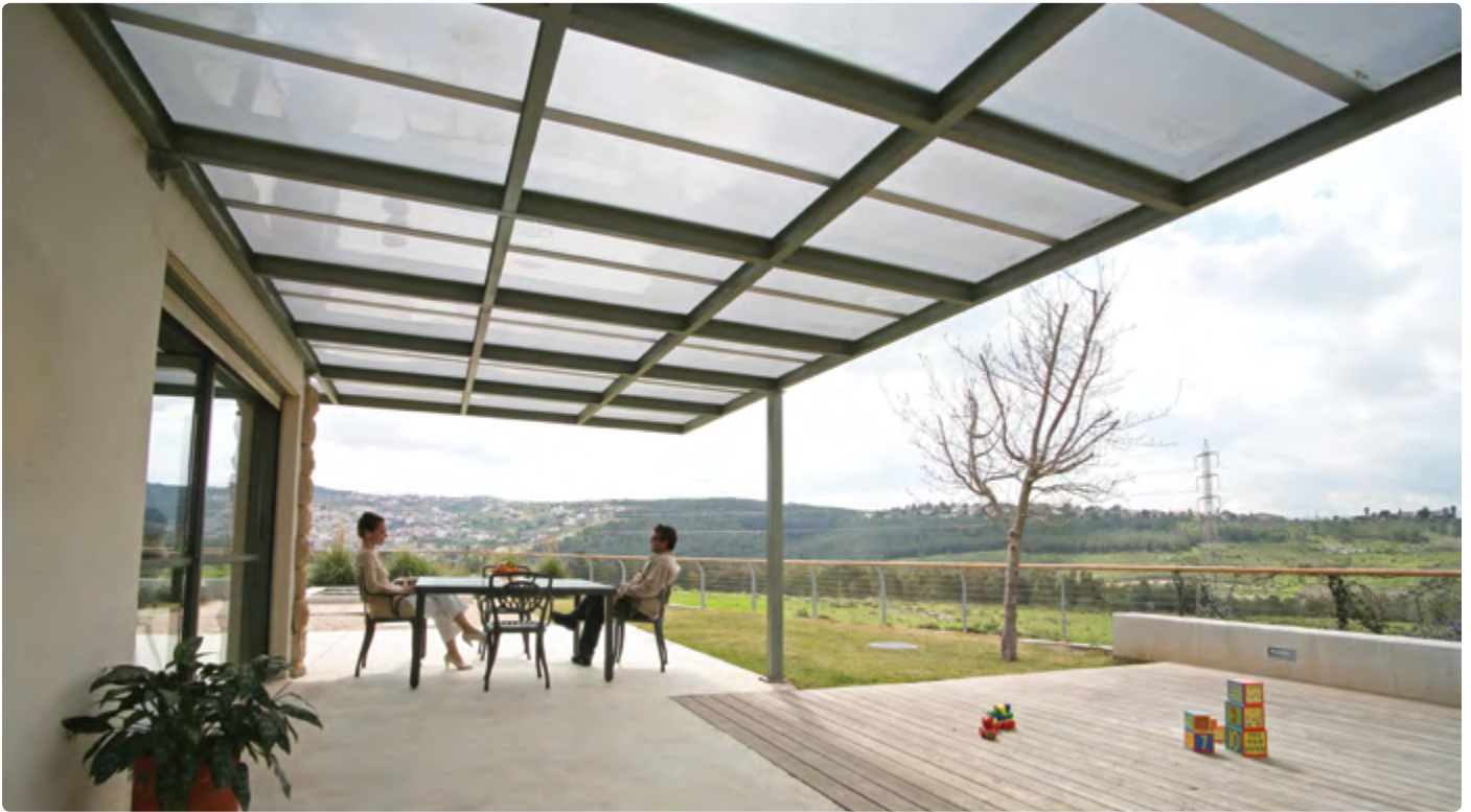
בית פרטי - ישראל | יישום: פרגולה אדריכלית - 70 מ"ר | סוג סנגלייזינג: סולר קונטרול 3/600 מ"מ
